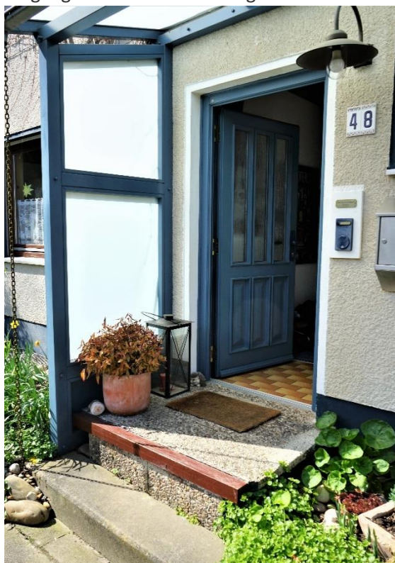
Eingangstür mit Überdachung und Windschutz
