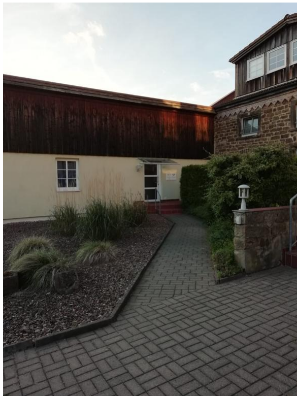
Nebengebäude mit der Wohnung
