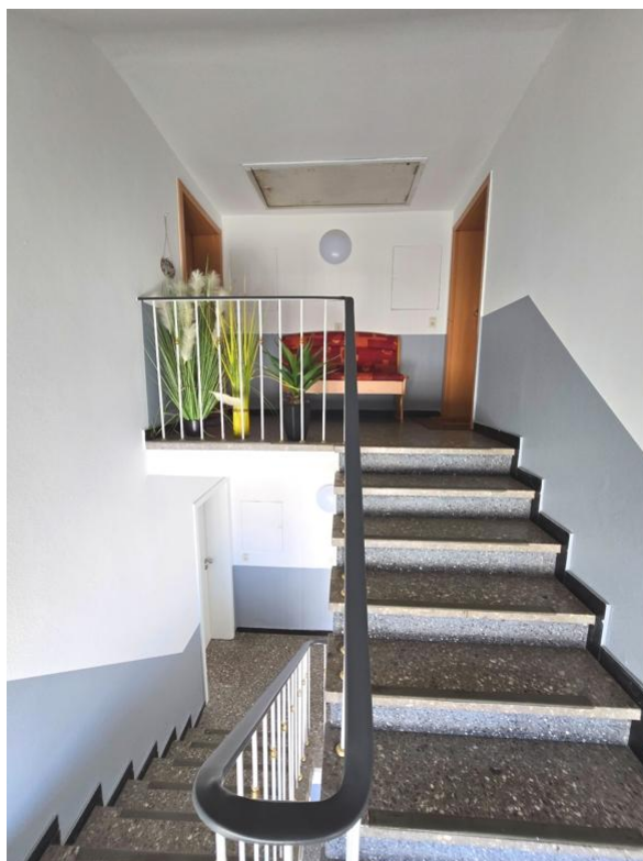
Treppe, Flur zum DG
