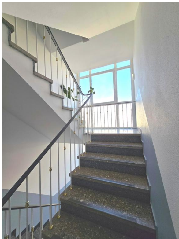
Treppe zum 2. OG
