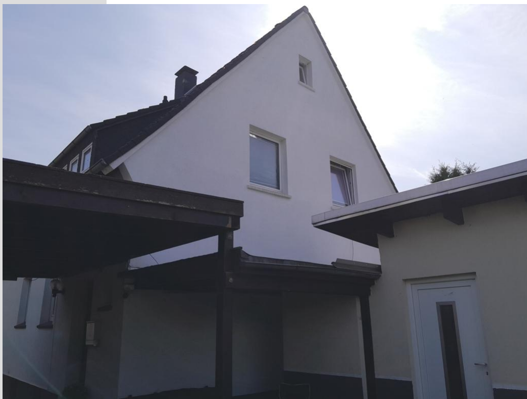
Anbau und Carport
